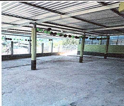
Foto 5: Sustitución de piso de granito.
