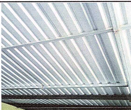
Foto 3: Sustitución de estructura de soporte de madera, por metal.
