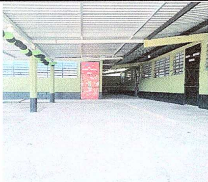
Foto 1: Sustitución de piso granito.
