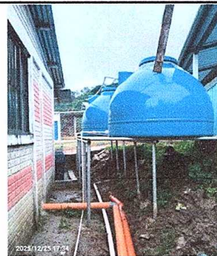
Foto 6: Sustitución de depósito de agua 2500 lt
