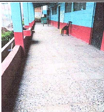
Foto 1: Sustitución de piso de granito
