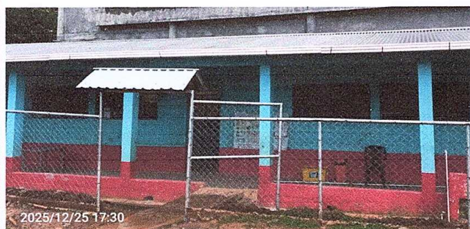
Foto 3: Sustitución de canal de pvc
