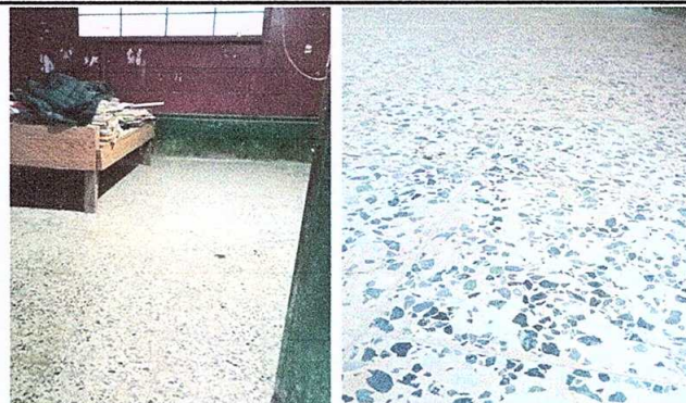
Foto 2: Sustitución de piso de granito
