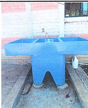
Foto 5: Sustitución de pila plástica de dos lavaderos
