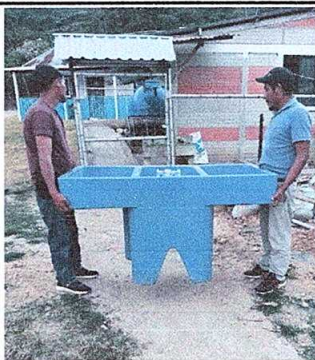
Foto 5: Sustitución de pila plástica de dos lavaderos
