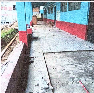
Foto 1: Sustitución de piso de granito
