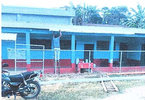
Foto 3: Sustitución de canal de pvc
