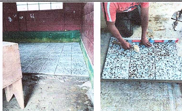
Foto 2: Sustitución de piso de granito
