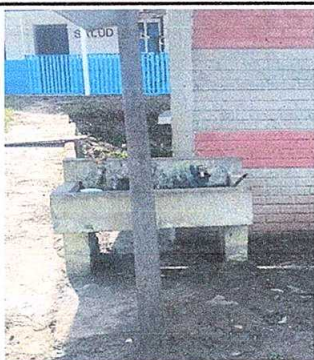
Foto 5: Sustitución de pila plástica de dos lavaderos
