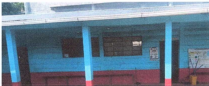
Foto 3: Sustitución de canal de pvc
