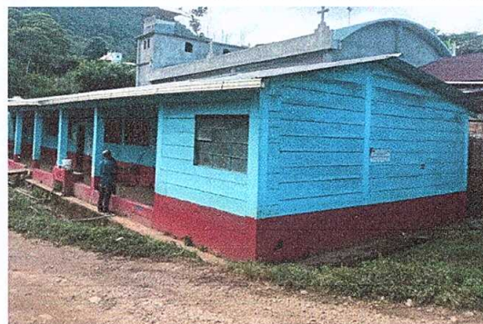
Foto 4: Reparación de tubo hg y malla galvanizada
