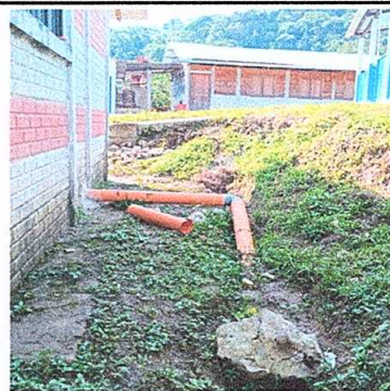
Foto 6: Sustitución de depósito de agua 2500 lt
