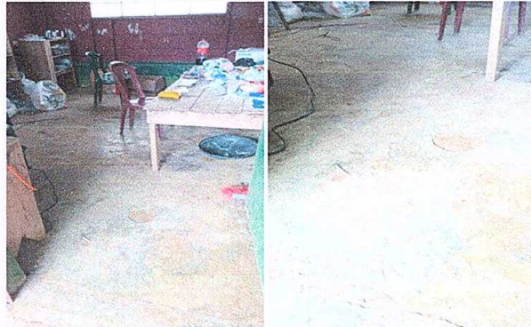
Foto 2: Sustitución de piso de granito
