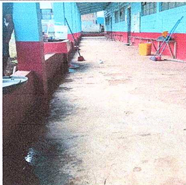
Foto 1: Sustitución de piso de granito
