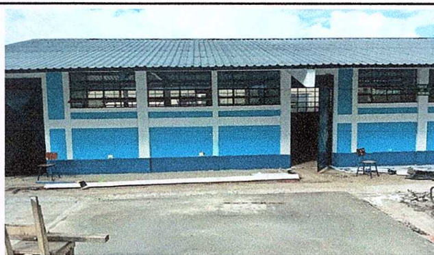
Foto 4: Aplicación de pintura en exterior.
