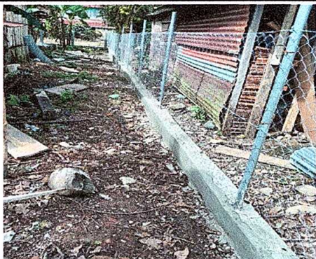
Foto 13: Sustitución de tubo HG y malla galvanizada.
