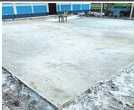
Foto 12: Reparación de planchas de concreto de patio.
