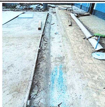
Foto 10: Reparación de cuneta de concreto.
