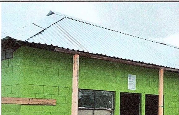
Foto 9: Sustitución de lámina, por lámina troquelada aluzinc calibre 26.
