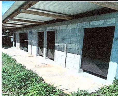
Foto 8: Sustitución de puertas de madera por metal.
