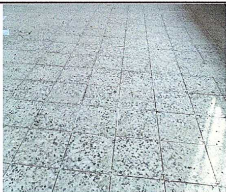
Foto 3: Sustrucción de piso, por piso de granito en mal estado.
