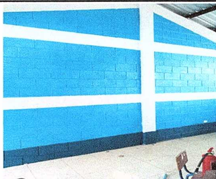
Foto 5: Aplicación de pintura en interior.
