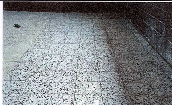
Foto 2: Sustrucción de piso, por piso de granito en mal estado.
