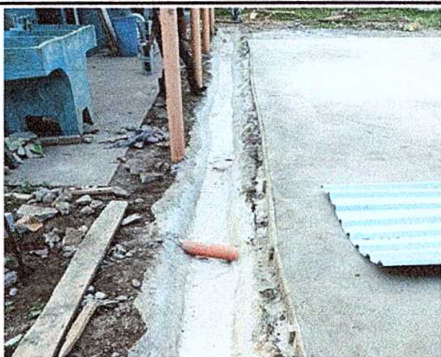
Foto 11: Reparación de cuneta de concreto.
