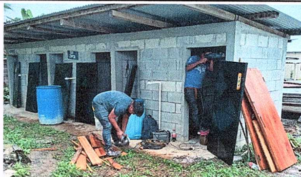
Foto 8: Sustitución de puertas de madera por metal.
