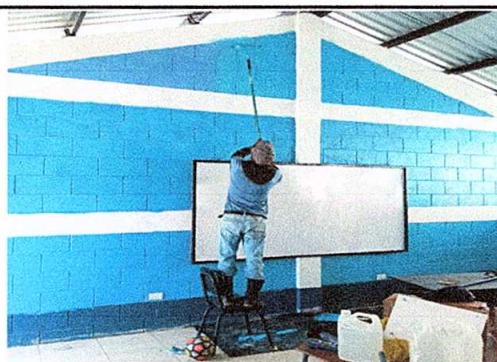
Foto 5: Aplicación de pintura en interior.
