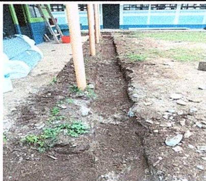
Foto 11: Reparación de cuneta de concreto.
