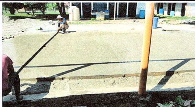
Foto 12: Reparación de planchas de concreto de patio.
