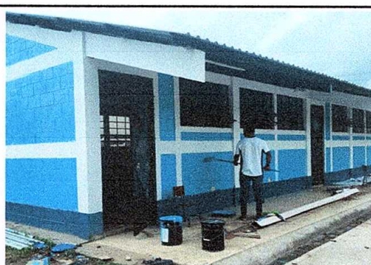
Foto 4: Aplicación de pintura en exterior.
