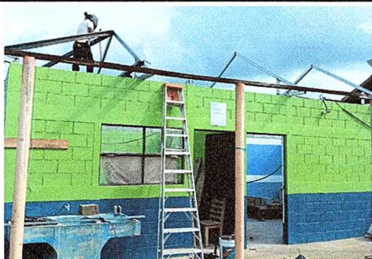
Foto 9: Sustitución de lámina, por lámina troquelada aluzinc calibre 26.
