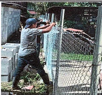
Foto 13: Sustitución de tubo HG y malla galvanizada.
