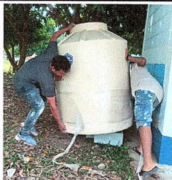
Foto 14: Sustitución de depósito de agua de 1100 litros.
