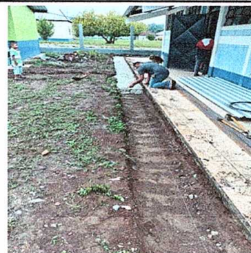
Foto 10: Reparación de cuneta de concreto.
