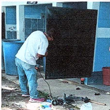
Foto 7: Reparación de puertas.
