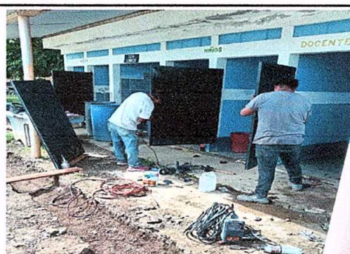
Foto 6: Mantenimiento a estructura, lijado, aplicación de pintura y sujeción.
