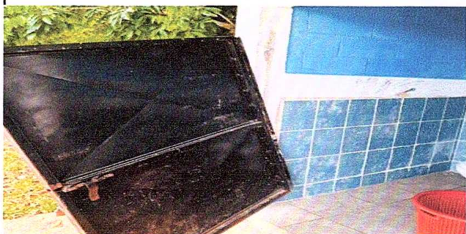
Foto 7: Reparación de puertas
