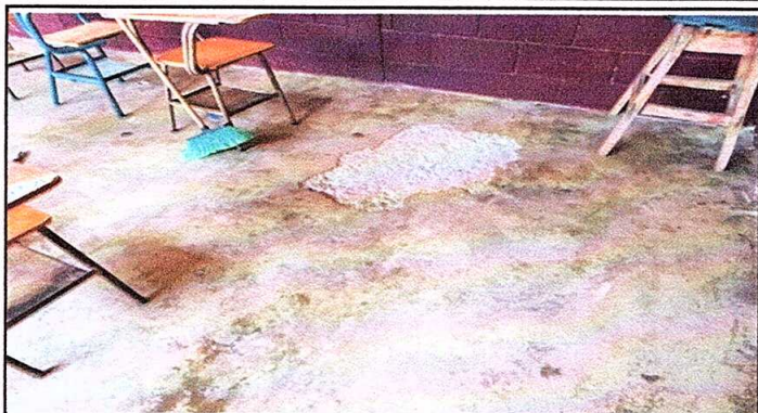
Foto1: Sustitución de piso, por piso de granito en mal estado.
