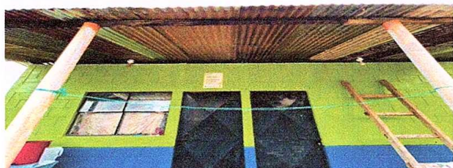
Foto 9: Sustitución de lámina, por lámina troquelada alucín calibre 26
