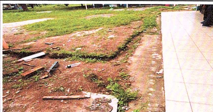
Foto 10: Reparación de cuneta de concreto
