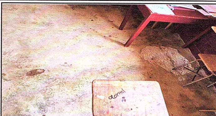
Foto 2: Sustitución de piso, por piso de granito en mal estado.
