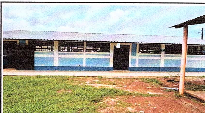
Foto 4: Aplicación de pintura en exterior
