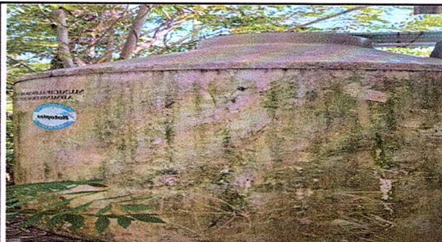
Foto 14: Sustrucción de deposito de agua de 1100 litros
