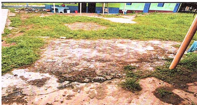
Foto 12: Reparación de planchas de concreto de patio
