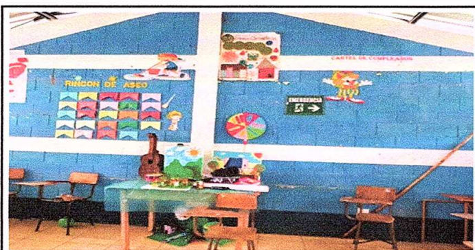
Foto 5: Aplicación de pintura en interior
