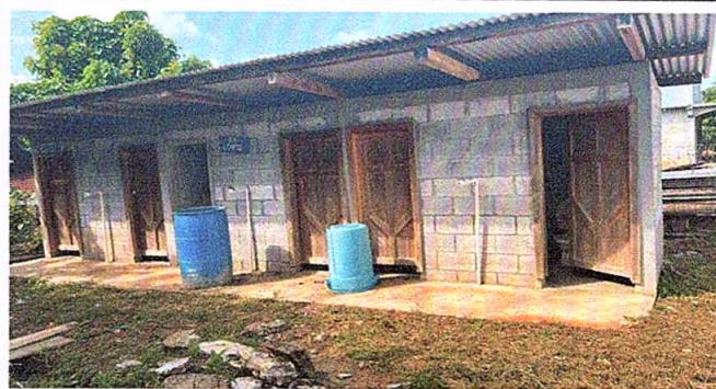
Foto 8: sustitución de puertas de madera por metal
