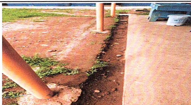
Foto 11: Reparación de cuneta de concreto
