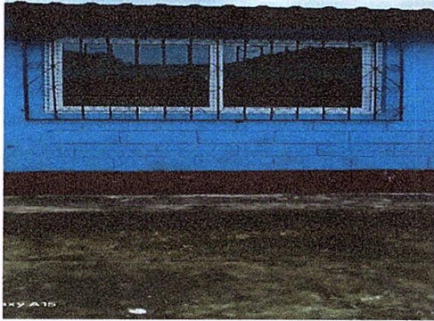
Foto7: Sustrucción de ventanas de metal mas vidrio
