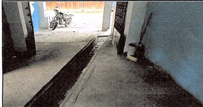
Foto 2: Susutitucion de piso de torta de concreto.
