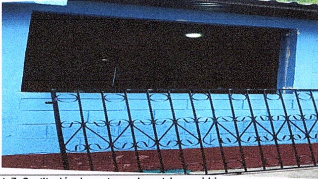
Foto7: Sustitución de ventanas de metal mas vidrio
