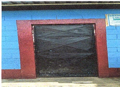
Foto 8: Mantenimiento de puerta.
