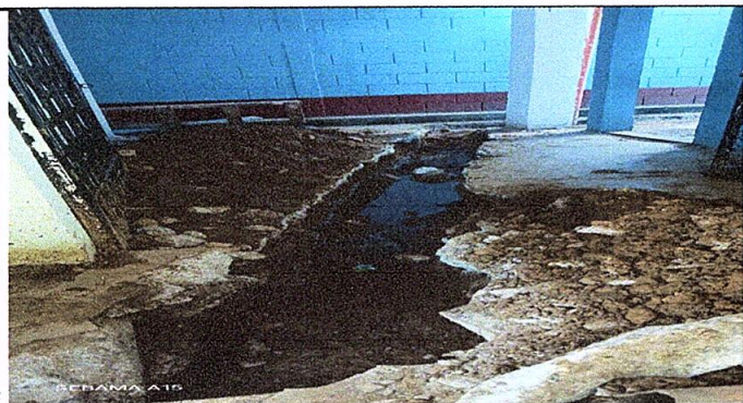
Foto 5: Reparacion de cunetas
