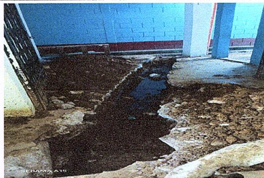
FOTO 6: Instalación de parillas para cunetas
