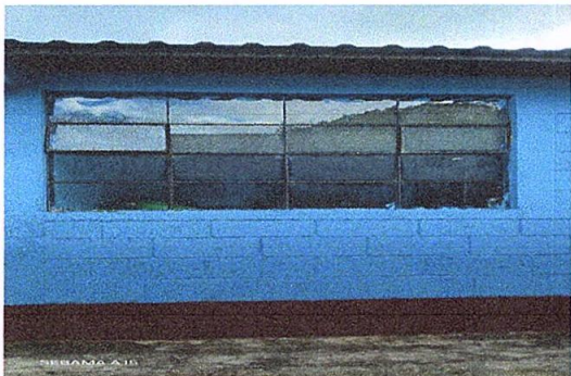
Foto7: Sustrucción de ventanas de metal mas vidrio
