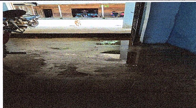
Foto 2: Susutitucion de piso de torta de concreto.
