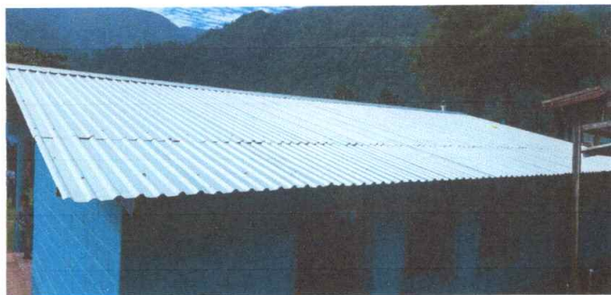
Foto1: CUBIERTA DE LÁMINA
