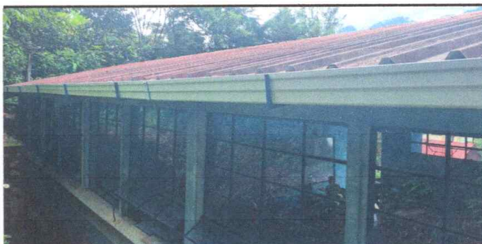
Foto 06: CANALES Y BAJADAS DE AGUA PLUVIAL
