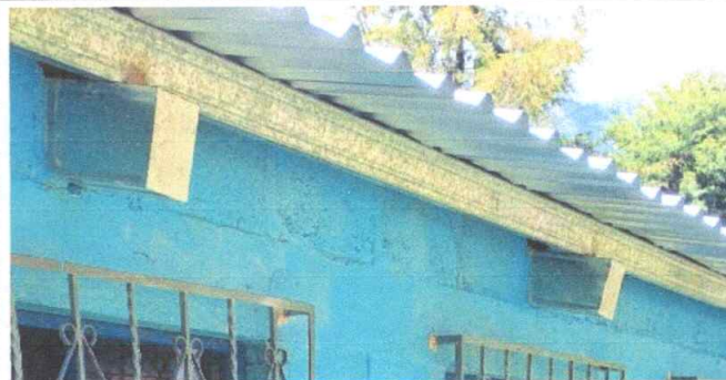
Foto 06: CANALES Y BAJADAS DE AGUA PLUVIAL
