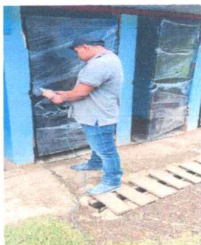
Foto 03: PUERTAS DE METAL
