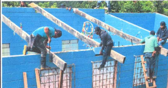
Foto 2: ESTRUCTURA DE TECHO
