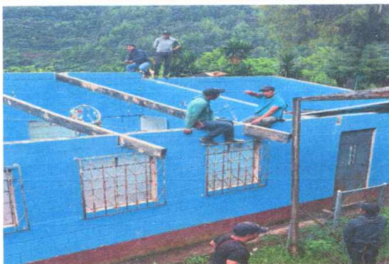
Foto1: CUBIERTA DE LÁMINA
