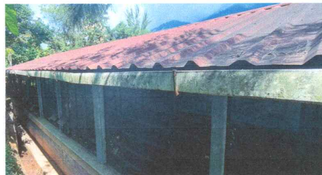
Foto 06: CANALES Y BAJADAS DE AGUA PLUVIAL
