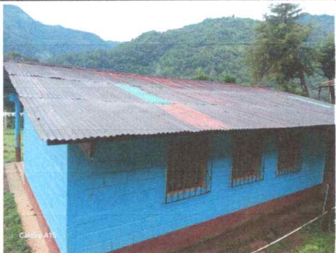
Foto1: CUBIERTA DE LÁMINA
