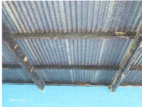
Foto 2: ESTRUCTURA DE TECHO
