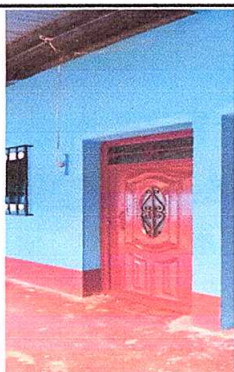
Foto 3: Sustitución de 8 puertas
