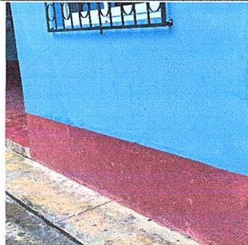
Foto 6: Pinturas en muros exteriores e interiores
