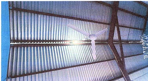
Foto7: Sustitucion de focos ahorradores
