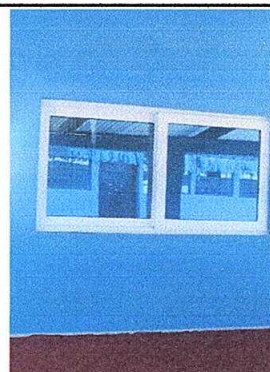
Foto 4: Sustitución de 13 ventanas de metal por PVC mas vidrio
