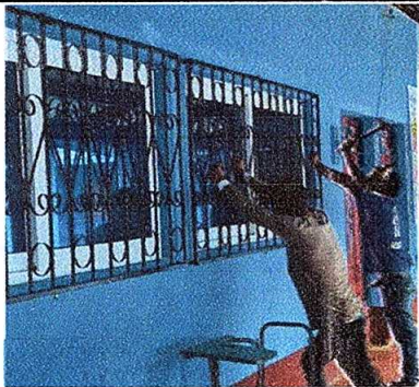
Foto 5: Mantenimiento de 16 balcones de metal
