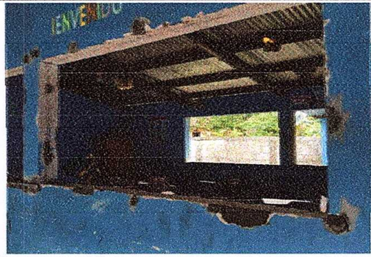
Foto 4: Sustrucción de 13 ventanas de metal por PVC mas vidrio
