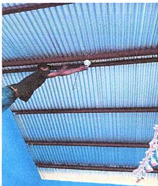
Foto1: Sustitucion de focos ahorradores
