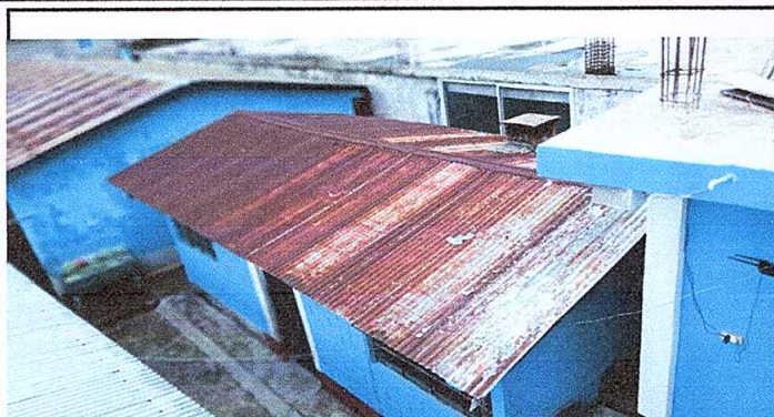
Foto 1: Sustitucion de lamina
