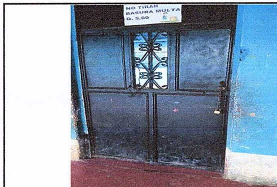
Foto 3: Sustitucion de puertas
