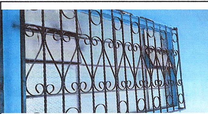
Foto 4: Sustitucion de ventanas
