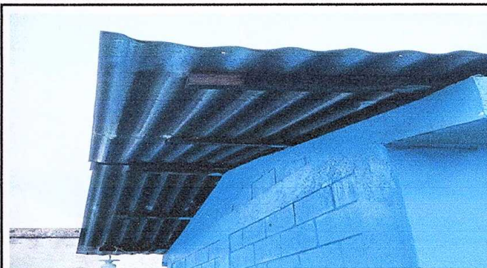
Foto 2: Sustitucion de estructura de soporte
