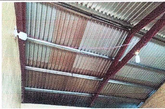
Foto 8: Sustitución de focos y cables en las aulas.
