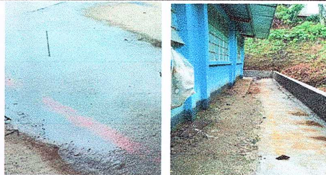
Foto 6: Fundición de cunetas de la escuela.
