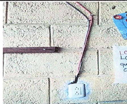
Foto 10: Sustitución de tomacorrientes e interruptores.
