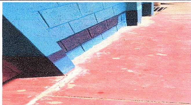
Foto 7: Reparación de banquetas de la escuela
