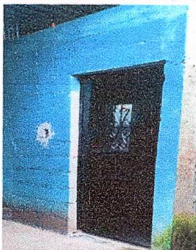
Foto 1: Sustrucción de puerta de madera por metal
