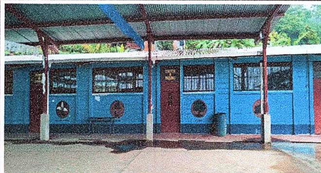
Foto 4: Balcones de metal en ventanas de las aulas.
