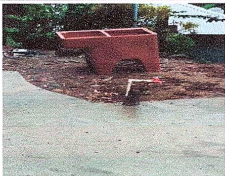
Foto 11: Pila de la cocina en mal estado.
