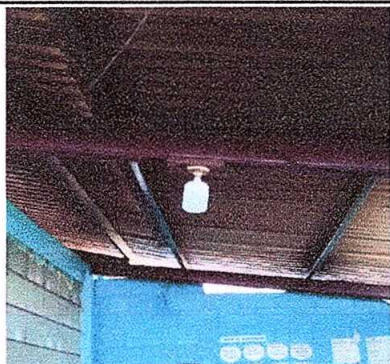
Foto 9: Sustitución de focos y cables en cocina
