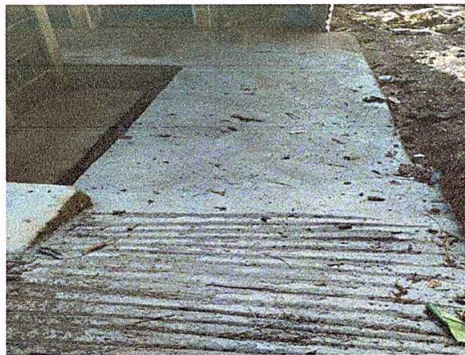
Foto 12: Losa de concreto del patio en mal estado.
