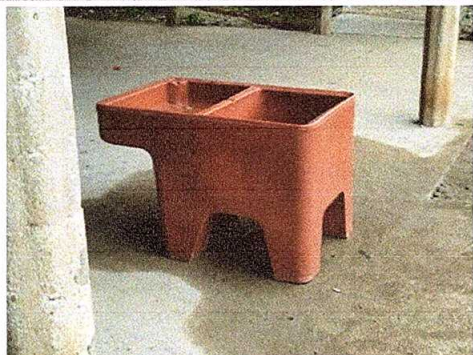
Foto 11: Pila de la cocina en mal estado.
