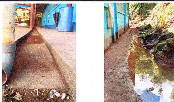
Foto 6: Cunetas de la escuela en mal estado y que provocan propagación de mosquitos.
