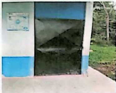
Foto 7: SUSTITUCIÓN DE PUERTA
