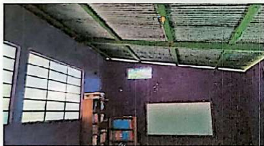
Foto 9: APLICACIÓN DE PINTURA EN MUROS EXTERIORES E INTERIORES
