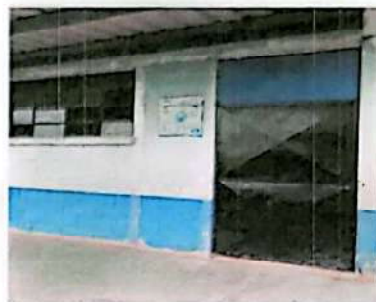
Foto 8: SUSTITUCIÓN DE PUERTA
