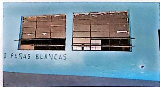
Foto 6: SUSTITUCIÓN DE VENTANAS POR BALCONES
