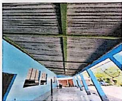
Foto 3: SUSTITUCIÓN DE ESTRUCTURA PORTANTE DE MADERA POR METAL
