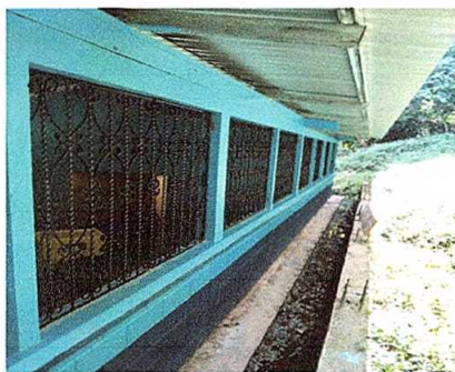
Foto 5: Ventanas en malas condiciones y sustituidas por balcones para una buena ventilación
