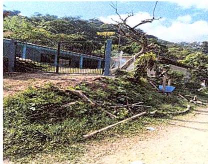
Foto 1: Circulación en malas condiciones
