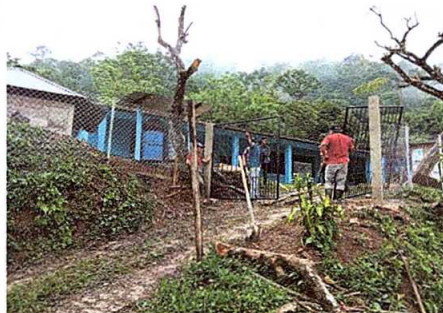
Foto 4: Portón en malas condiciones
