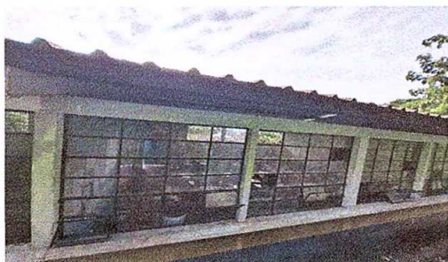
Foto 5: Ventanas en malas condiciones y sustituidas por balcones para una buena ventilación
