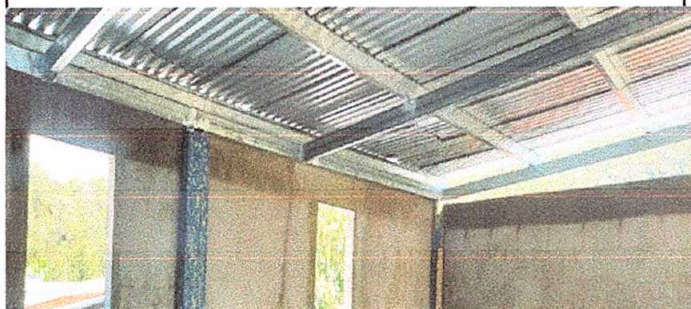
Foto1: sustitución de lámina, por lámina troquelada Aluzinc 16.
