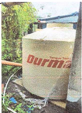
Foto 7: Sustitución de depósito de agua 2500 lt
