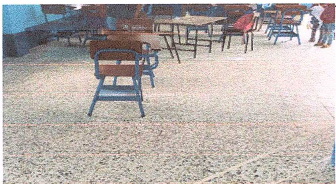
Foto 5: Sustitución de piso de granito
