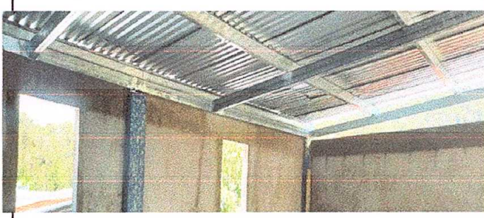
Foto 2: Sustitucion de estructura de soporte de metal, por metal
