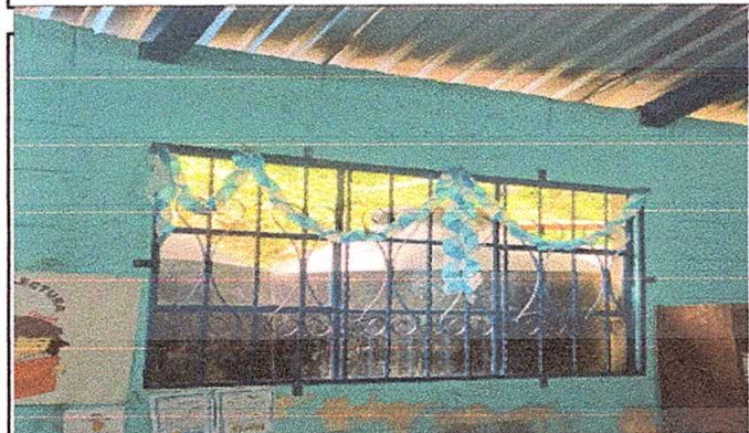
Foto 3: Sustitucion de vidrios
