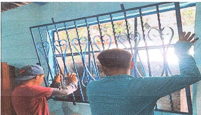
Foto 4: Sustitución de balcones de metal
