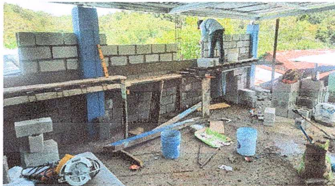
Foto 8: construcción de pared
