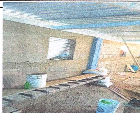
Foto 10: ventanas de PVC
