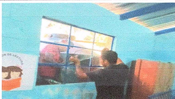
Foto 3: Sustitucion de vidrios
