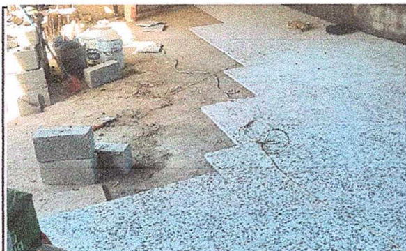
Foto 5: Sustitución de piso granito
