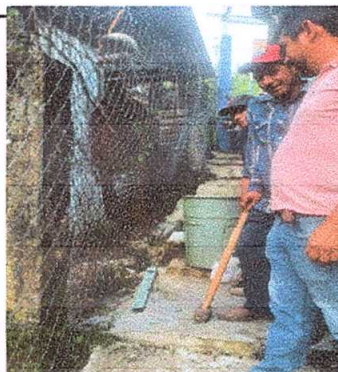
Foto 6: reparación de tubo HG y malla galvanizada
