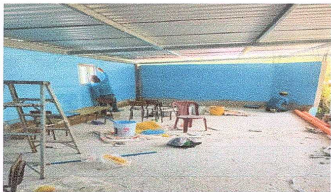
Foto 9: pintura en muros interior y exterior
