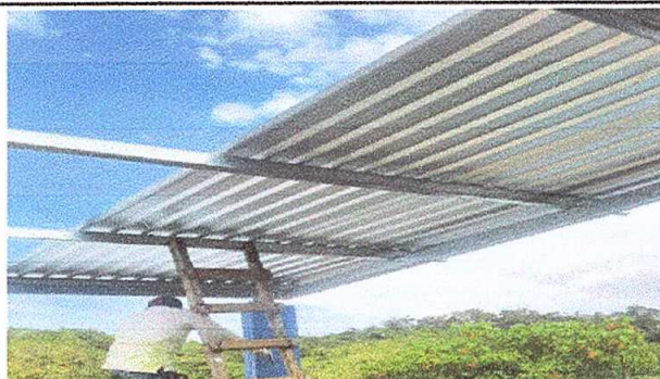
Foto1: sustitución de lámina, por lámina troquelada Aluzinc 16.
