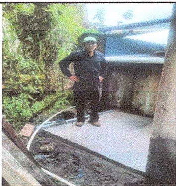
Foto 7: Sustitución de depósito de agua 2500 lt
