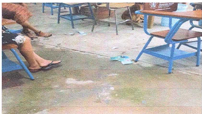
Foto 5: Sustitución de piso de granito
