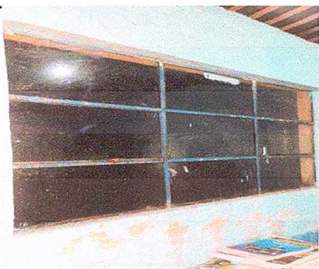
Foto 3: Sustitucion de vidrios
