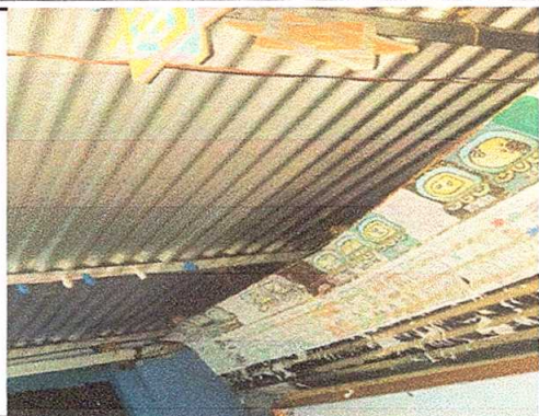
Foto1: sustitución de lámina, por lámina troquelada Aluzinc 16.
