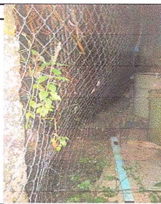
Foto 6: reparación de tubo HG y malla galvanizada
