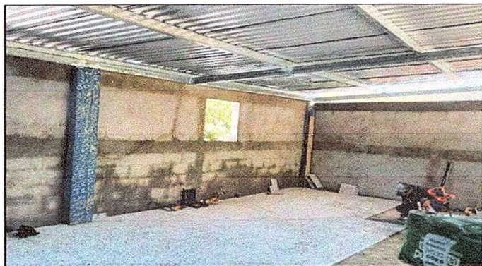
foto 9: pinturas en muro interior y exterior
