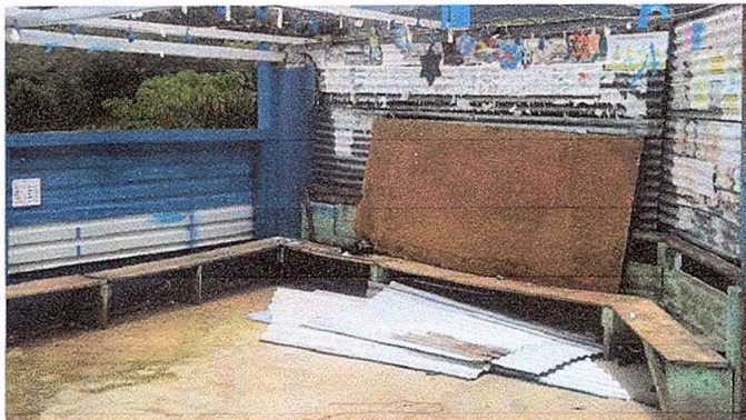
Foto 8: construcción de pared de aula.
