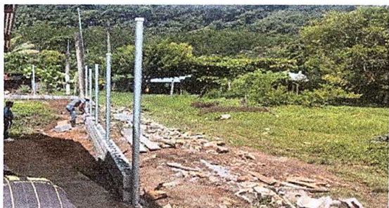
Reparación de tubo hg y malla galvanizada durante el proceso
