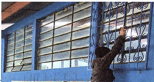
Sustitución de ventanas de madera por metal mas vidrio durante el proceso
