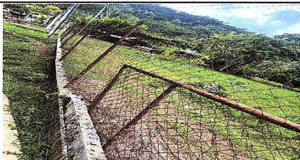
Reparación de tubo hg y malla galvanizada antes
