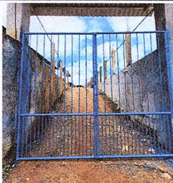
Foto1: Mantenimiento a estructura de portón.
