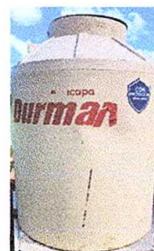
Foto8: Sustitución de depósito de agua 1100 lt.
