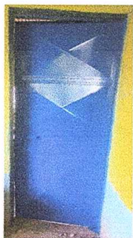
Foto1: Mantenimiento a estructura.
