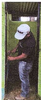
Foto 2: Sustitución de puerta.
