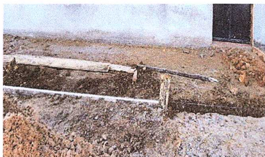
Foto 9: Sustitución de piso de torta de concreto.
