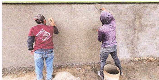
Foto 10: Repello en muro
