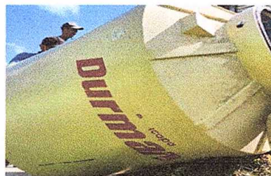
Foto8: Sustitución de depósito de agua 1100 lt.
