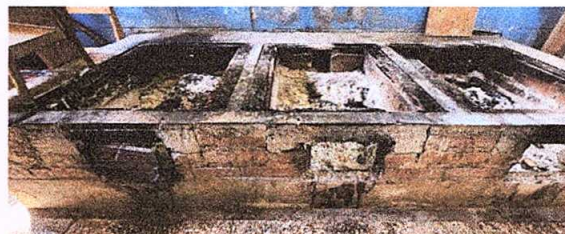
Foto 4: Sustitución de plancha de metal de 3 hornillas
