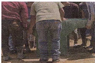
Foto7: Sustitución de pila de cemento de dos lavaderos.
