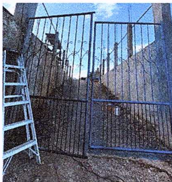
Foto1: Mantenimiento a estructura de portón.
