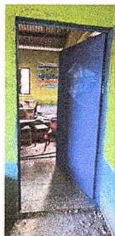
Foto 1: Mantenimiento a estructura.
