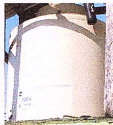
Foto8: Sustrucción de depósito de agua 1100 lt.
