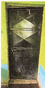
Foto 1: Mantenimiento a estructura.
