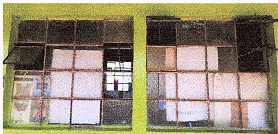
Foto 3: Sustitución de estructura de metal de ventana.
