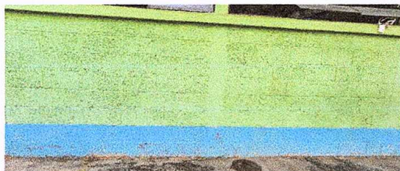
Foto 5: Pintura en muros exteriores e interiores.
