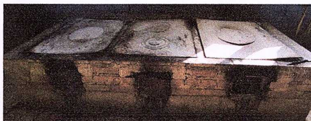
Foto 4: Sustitución de plancha de metal de 3 hornillas
