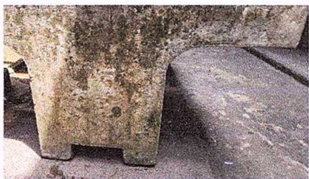
Foto7: Sustrucción de pila de cemento de dos lavaderos.
