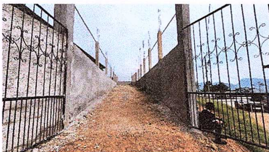
Foto1: Mantenimiento a estructura de portón.
