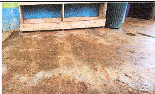
Foto 9: Sustrucción de piso de torta de concreto.
