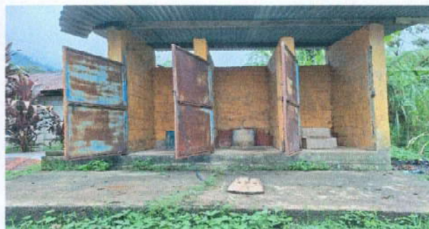
Foto 8: Sustitución de inodoro en mal estado.
