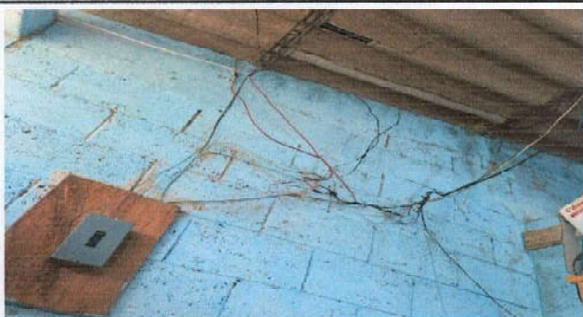
Foto 9: Reparación de cableado eléctrico.
