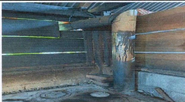
Foto 10: Sustitución de chimenea por chimenea de concreto
