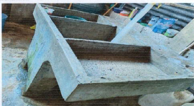
Foto 11: Sustitución de pila de concreto.
