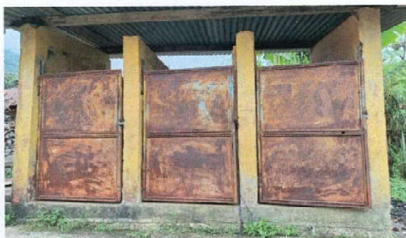
Foto 3: Sustitución de puertas por puertas en mal estado.
