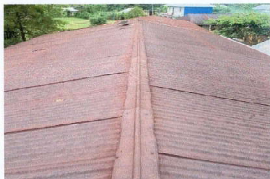
Foto 1: Sustitución de lámina, por lámina troquelada aluzinc calibre 26, sustitución de capote de lámina para lámina troquelada y sustitución de elementos de fijación.
