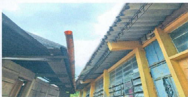
Foto 7: Sustitución de canal pvc.
