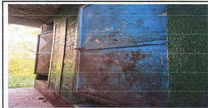
Foto 5: Sustitución de puertas de metal 0.80 x 1.90 ms, puertas de metal, servicios sanitario sin chapa.
