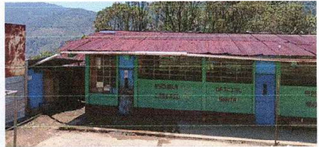
Foto 2: Sustitución de capote para lamina troquelada aluzinc calibre 26.
