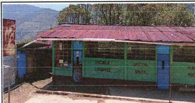
Foto 7: Sustitución de canal de PVC, sustitución de soporte o pescante de metal para canal.
