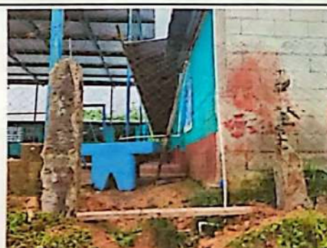
Foto 8.1: Reparación de muro perimetral con tubo hg y malla galvanizada.
