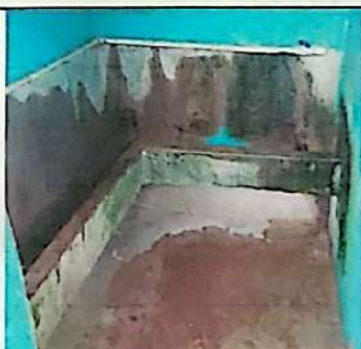
Foto 7.3: Sustrución de mingitorios
