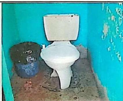
Foto 7.1: Sustrución de inodoro
