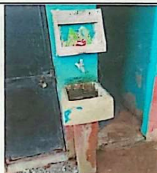
Foto 7.2: Sustrución de lavamanos
