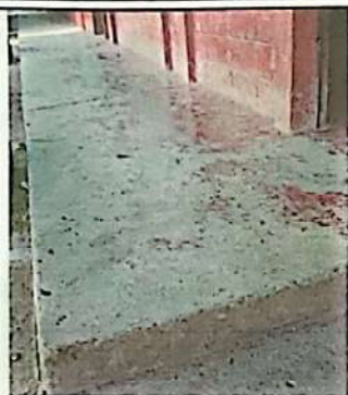
Foto 5: Sustrución de piso de concreto por piso de granito
