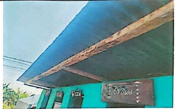
Foto 2.1: Sustitución de estructura de soporte de madera, por metálica
