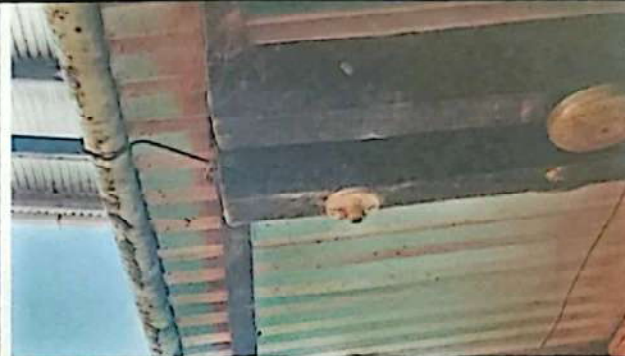
Foto 9.2: Sustitución de plafoneras
