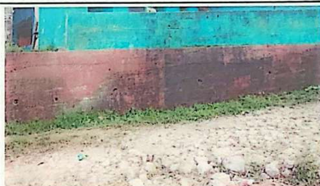
Foto 6: Aplicación de pintura en muros exteriores
