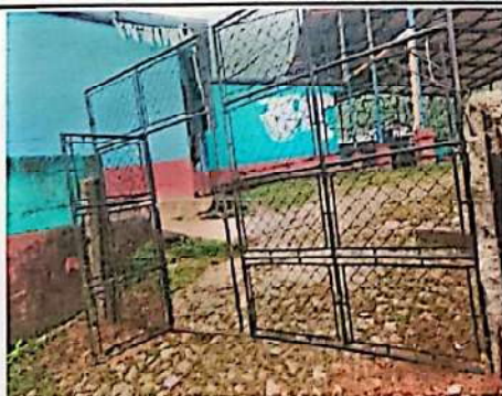
Foto 3.3: Sustitución de portón de metal de ingreso de 3.5m X 2.2m
