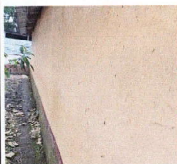
Foto 4: pintura en muros interiores y exteriores
