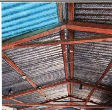
Foto 1: sustitución de estructura de soporte de madera por metal.
