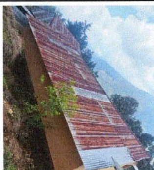
Foto 2: sustitución de lámina por lámina troquelada Aluzinc 26
