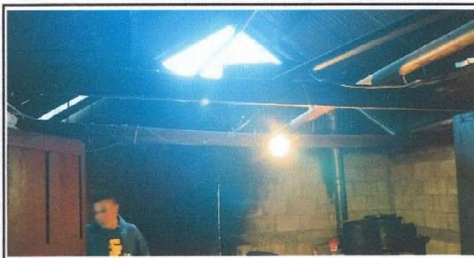
Foto 2: Sustrucción de estructura de madera por soporte de metal
