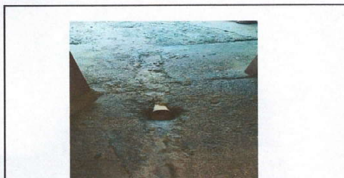
Foto 5: Reparación de piso cemento liquido
