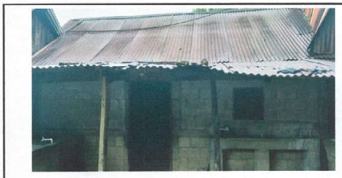
Foto 6: Pintura en muros interiores y exteriores
