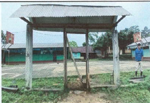
Foto 9: Sustitución de porton de metal
