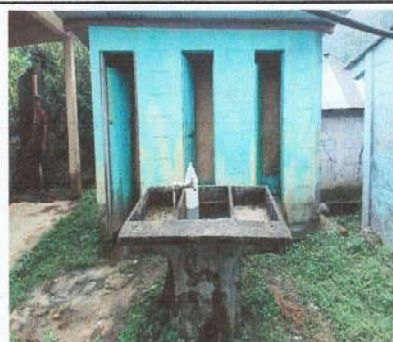
Foto 10: Sustitución de puertas en servicio sanitario
