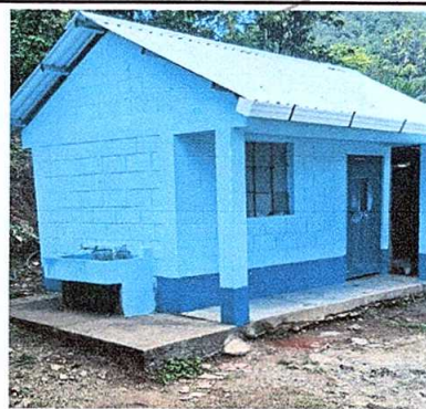
Foto 2: Soportes de madera en mal estado
