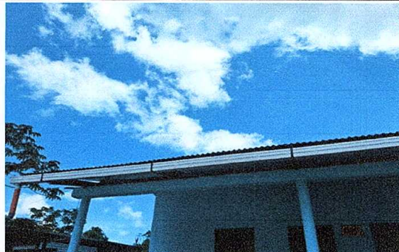
Foto 6: Canales, bajantes y pescantes en malas condiciones
