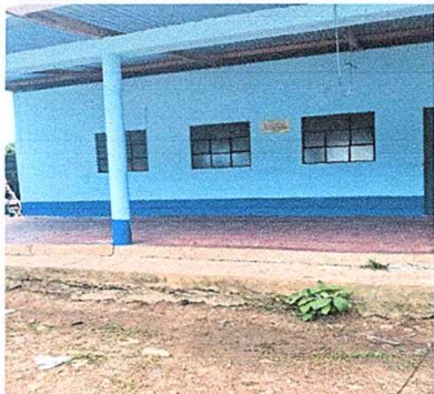
Foto 5: Ventanas de metal y vidrios en malas condiciones
