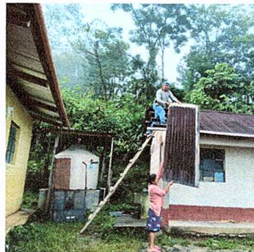
Foto 2: Soportes de madera en mal estado
