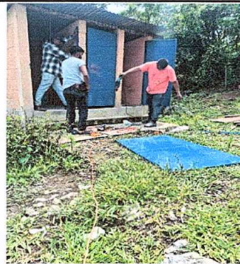
Foto 4: Puertas de baño en mal estado
