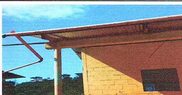
Foto 6: Canales, bajantes y pescantes en malas condiciones
