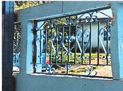
Foto 2: Sustitución de balcones de metal (1.50m*1m) (4 balcones)
