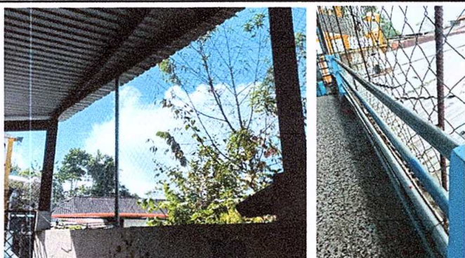
Foto 3: Reparación de tubo hg y malla galvanizada
