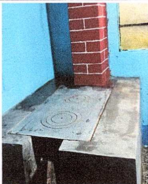
Foto 1: Sustitución de plancha de metal
