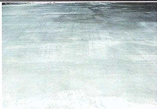
Foto 5: Sustitución de piso de granito
