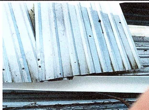
Foto 4: Sustitución de canal de pvc
