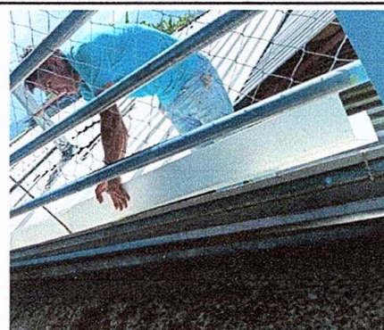
Foto 4: Sustitución de canal de pvc
