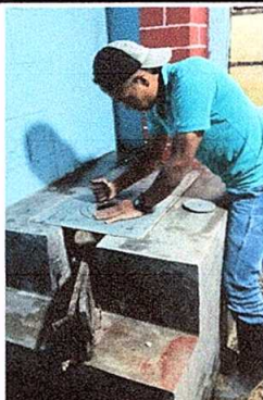
Foto 1: Sustitución de plancha de metal
