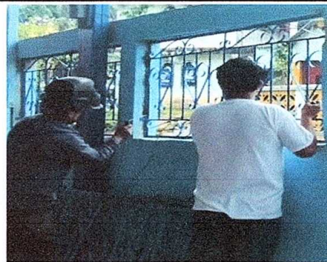
Foto 2: Sustitución de balcones de metal (1.50m*1m) (4 balcones)
