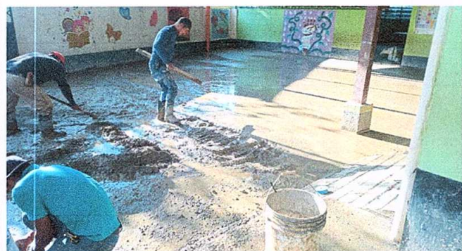
Foto 5: Sustitución de piso de granito
