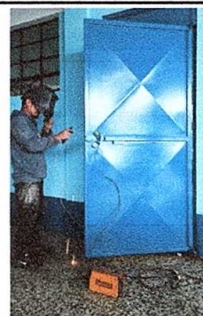
Foto 6: Sustitución de puerta (3.10m * 1.00m)
