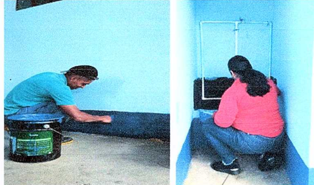
Foto 8: Pintura en muros exteriores e interiores.
