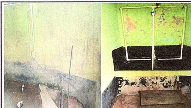
Foto 8: Pintura en muros exteriores e interiores
