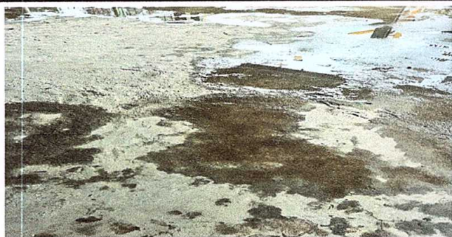
Foto 5: Sustitución de piso de granito
