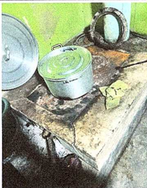
Foto1: Sustitución de plancha de metal
