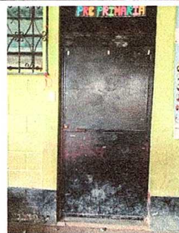
Foto 6: Sustitución de puerta (3.10m * 1.00m)
