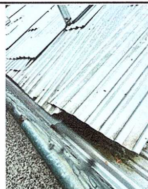
Foto 4: Sustitución de canal de pvc
