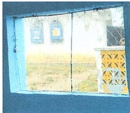
Foto 2: Sustitución de balcones de metal (1.50m*1m) (4 balcones)
