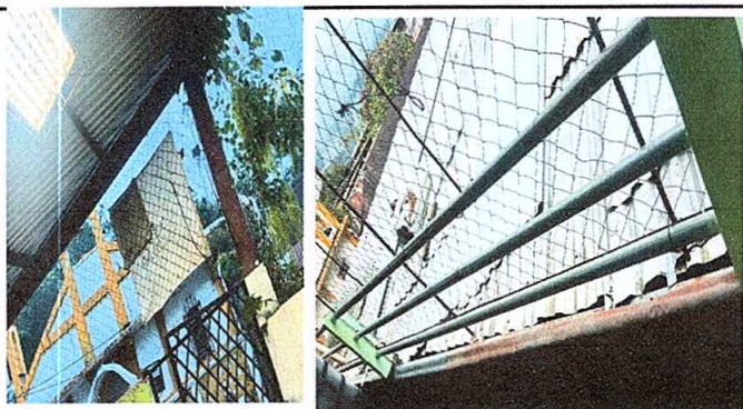
Foto 3: Reparación de tubo hg y malla galvanizada
