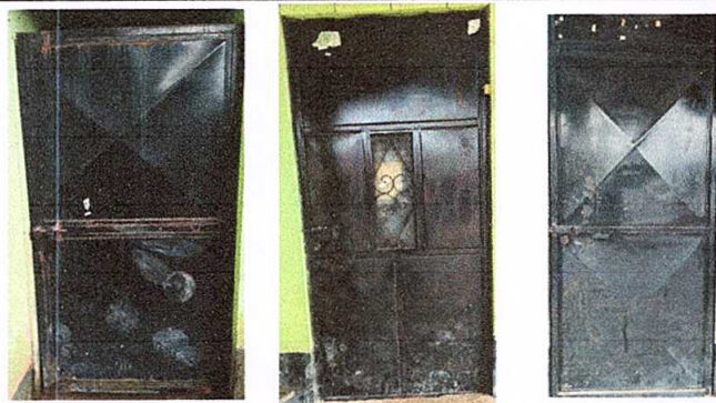
Foto7: Mantenimiento a estructura (lijado, cambio de tubo , cepillado, sujeciones, aplicación de pintura)
