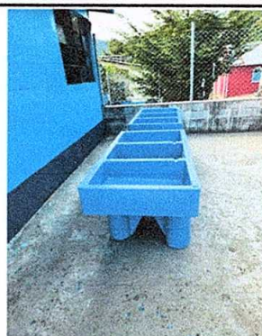
Foto 8: Sustitución de pila plástica de dos lavaderos.
