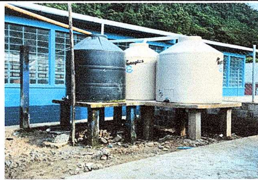
Foto 6: Sustrucción de deposito de agua 2500 lt.
