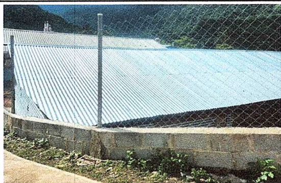
Foto 5: Reparación de tubo hg y malla galvanizada.
