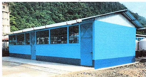
Foto 4: Pintura en muros exteriores e interiores.
