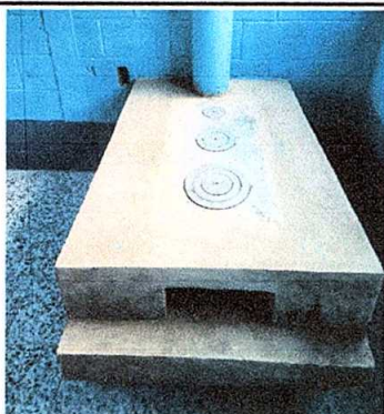
Foto 7: Sustitución de plancha de metal de 3 hornillas.
