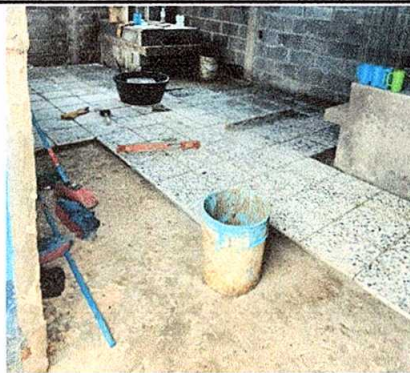
Foto 2: Sustitución de piso de granito.
