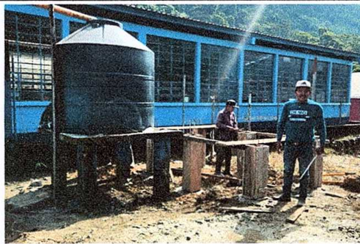
Foto 6: Sustitución de deposito de agua 2500 lt.
