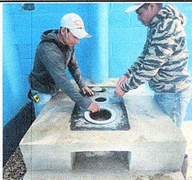
Foto 7: Sustitución de plancha de metal de 3 hornillas.
