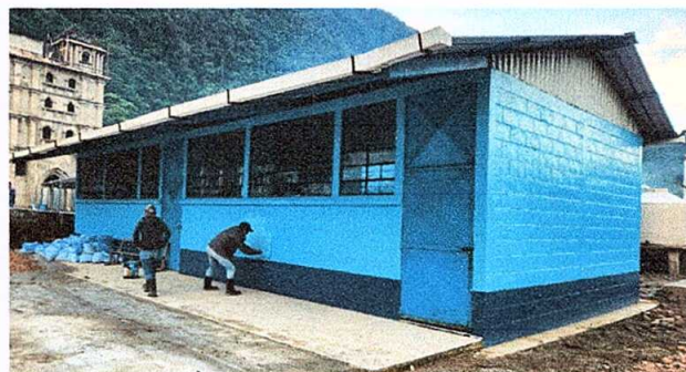
Foto 4: Pintura en muros exteriores e interiores.
