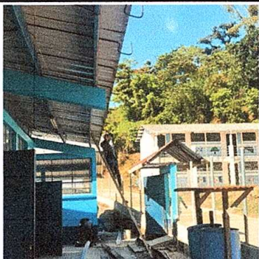
Foto 3: Sustitución de canal de pvc
