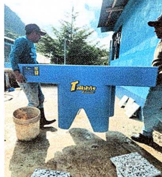
Foto 8: Sustitución de pila plástica de dos lavaderos.
