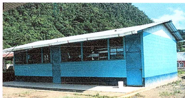
Foto 4: Pintura en muros exteriores e interiores.
