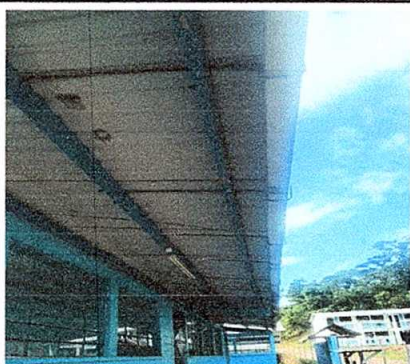
Foto 3: Sustrución de canal de pvc
