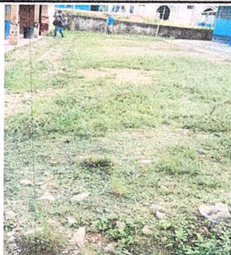
Foto 1: Sustrución de piso de torta de concreto.
