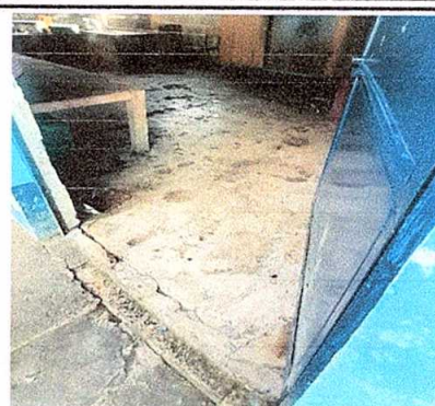
Foto 2: Sustrución de piso de granito.
