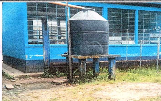
Foto 6: Sustrución de deposito de agua 2500 lt.
