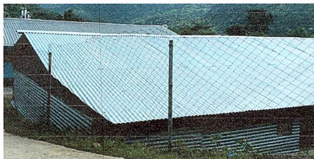
Foto 5: Reparación de tubo hg y malla galvanizada.
