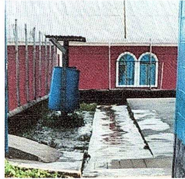
Foto 8: Sustrucción de pila plástica de dos lavaderos.
