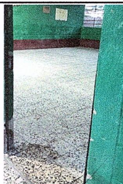
Foto 4: Sustitución de piso granito
