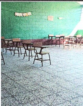
Foto 5: Sustitución de piso granito
