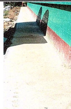
Foto 6: Sustitución de banquetas de concreto
