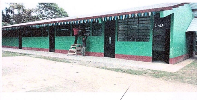
Foto 3: Sustitución de vidrios
