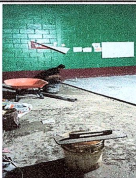
Foto 5: Sustitución de piso granito
