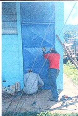
Foto1: Fabricación e instalación de puertas de 2.10 mts de alto por 1.05 mts de ancho.
