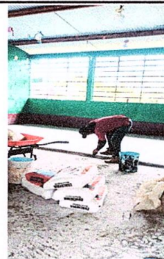
Foto 4: Sustitución de piso granito
