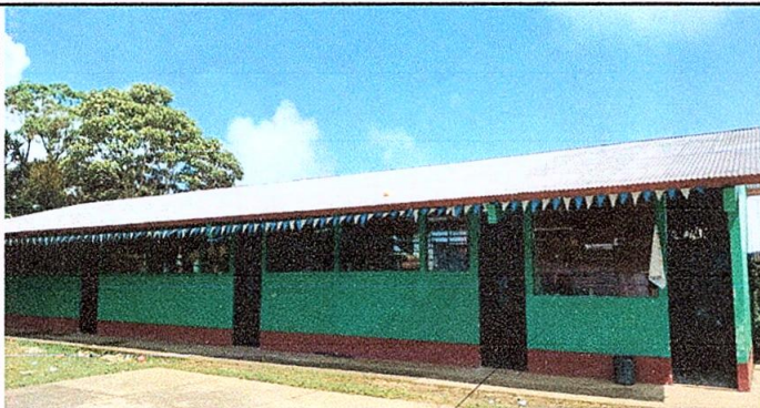
Foto 3: Sustitución de vidrios
