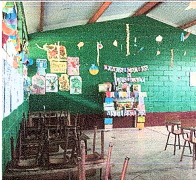
Foto 5: Sustitución de piso granito
