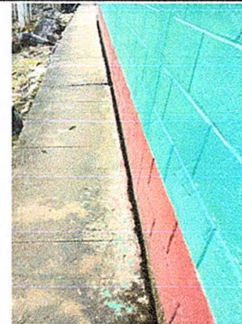
Foto 6: Sustitución de banquetas de concreto
