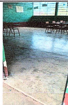
Foto 4: Sustitución de piso granito
