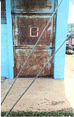
Foto 1: Fabricación e instalación de puertas de 2.10 mts de alto por 1.05 mts de ancho.
