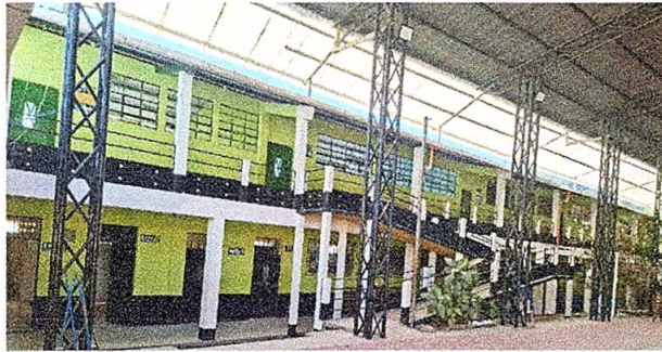
Foto 3: Sustrucción de barandas de metal
