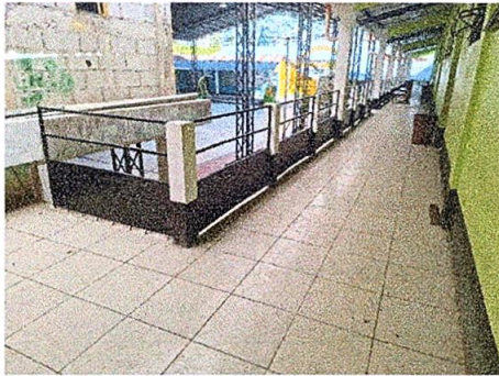
Foto 1: Sustrucción de barandas de metal
