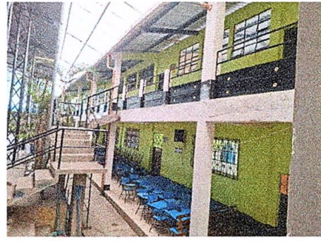
Foto 2: Sustrucción de barandas de metal.
