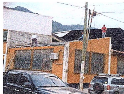
Foto 8: sustitución de lámina dirección.
