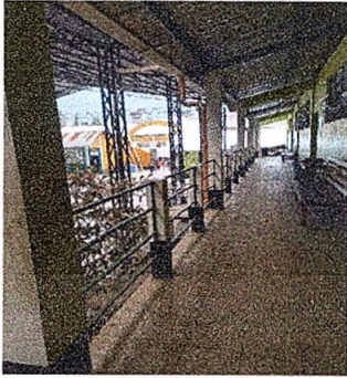
Foto 9: Sustrucción de barandas de metal
