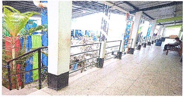
Foto 10: Sustrucción de barandas de metal.
