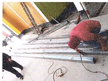
Foto 6: sustitución de estructura de soporte de madera, metal.
