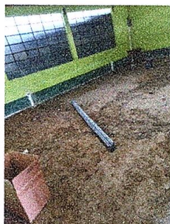
Foto 5: Sustitución de piso de secretaria.
